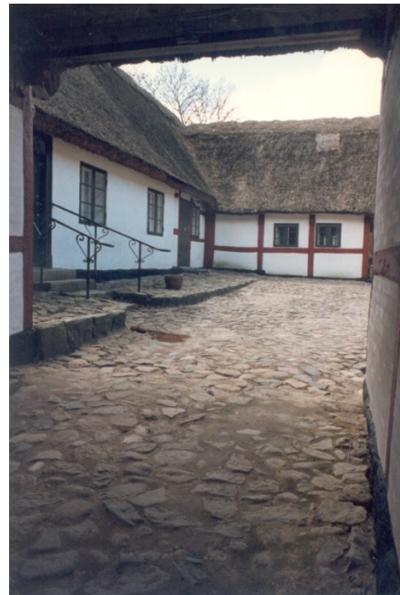
Hallisgården, Kornerup. Fredet 1984. Intakt anlæg.
